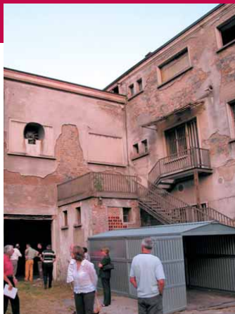
Interno e esterno dell'ex cinema di Piazza della Libertà
