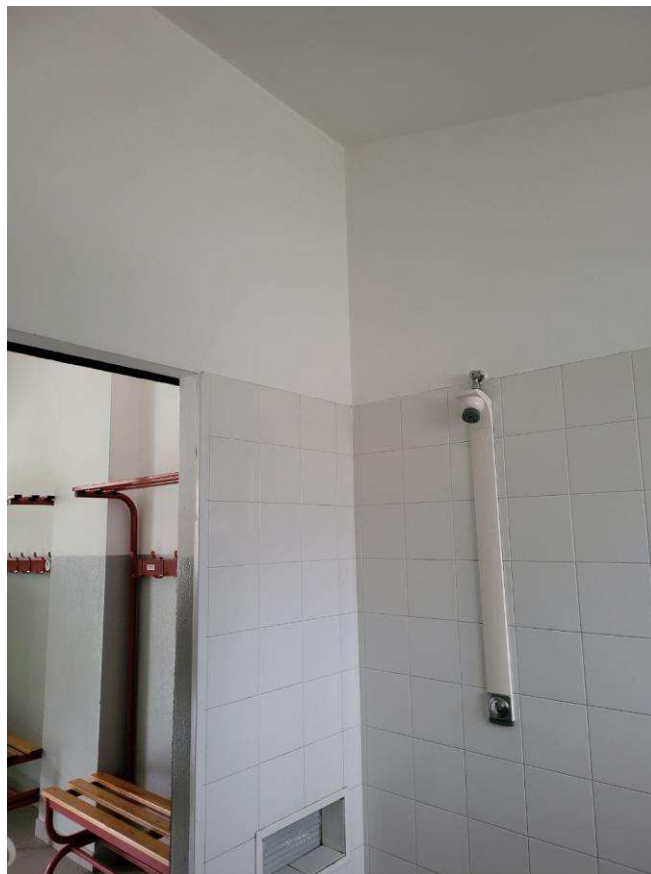
Foto 9 – Piano terra spogliatoi
