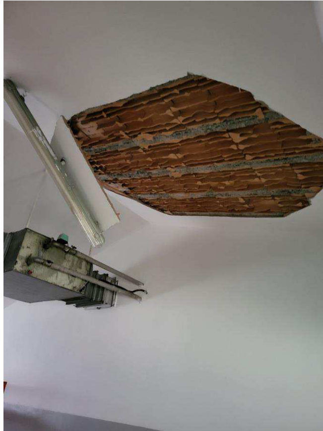
Foto 11 – Piano terra spogliatoi
