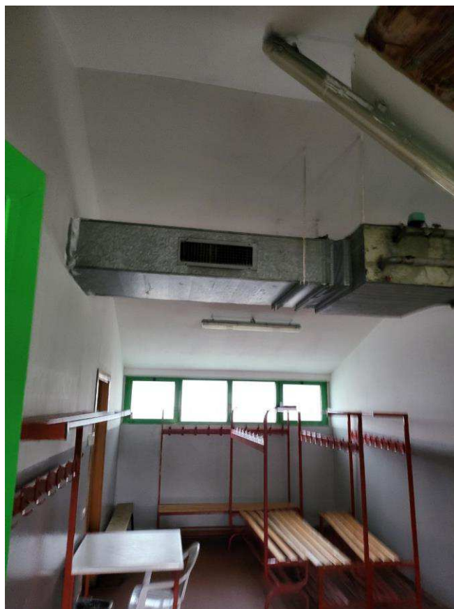
Foto 10 – Piano terra spogliatoi
