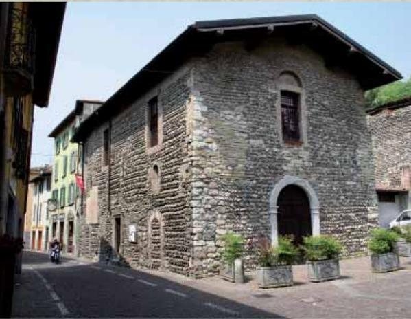
I materiali utilizzati nella costruzione sono poveri: *borlanti* (ciottoli arrotondati dall'azione dell'acqua) sistemati a lisca di pesce, spesso non disposti ordinatamente; pietre negli spigoli e inserite casualmente per i vari rimaneggiamenti; mattoni disposti principalmente intorno alle finestre.
