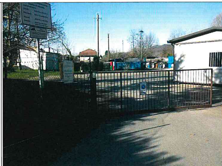
01. Centro di Raccolta – Cancelli di ingresso
