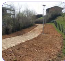
» STRADA PEDONALE VIA DEL FONTANELLI Termine dei lavori previsto per aprile 2022.
