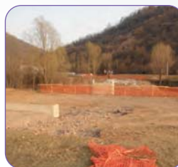
» PONTE 100 Termine dei lavori previsto per giugno 2022.
