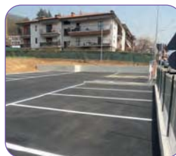
» PARCHEGGI VIA ALLE CASE DELLA VECCHIA Termine dei lavori previsto per aprile 2022.
