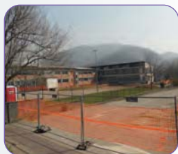
» PALAZZETTO Termine dei lavori previsto per giugno 2023.
